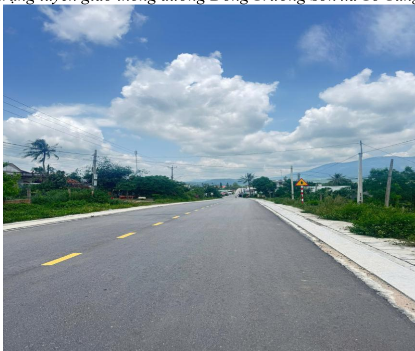
Hiện trạng trục giao thông đường trung tâm xã Tơ Tung (cũ)
