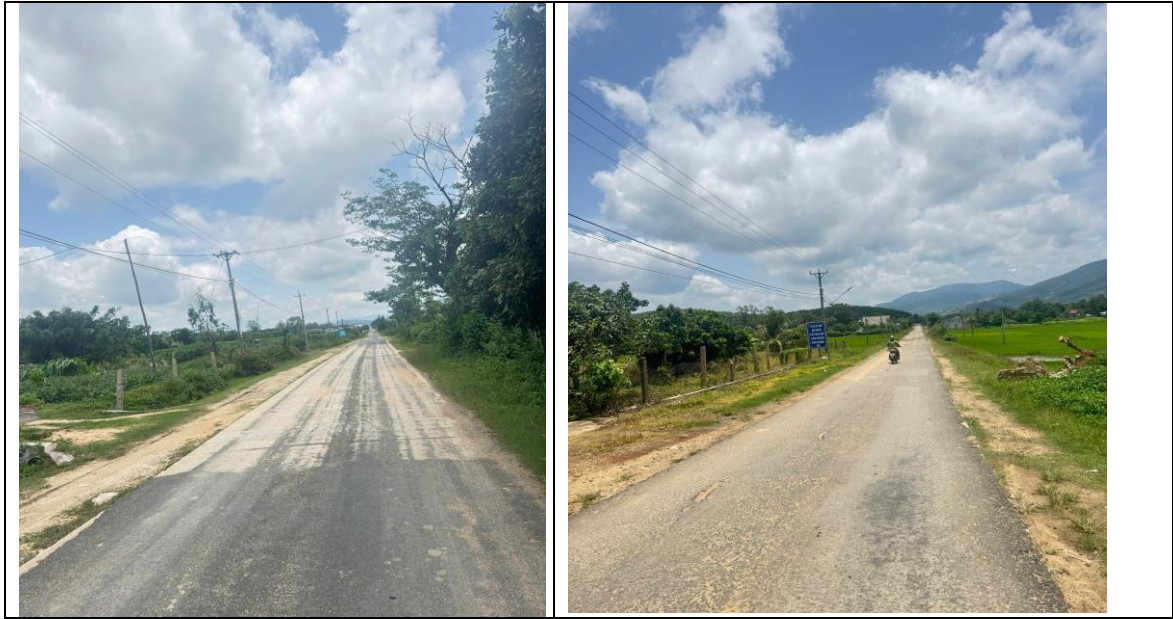
Hiện trạng trục giao thông đường trung tâm xã Tơ Tung (cũ) đi xã Kông Long Khong (cũ)
