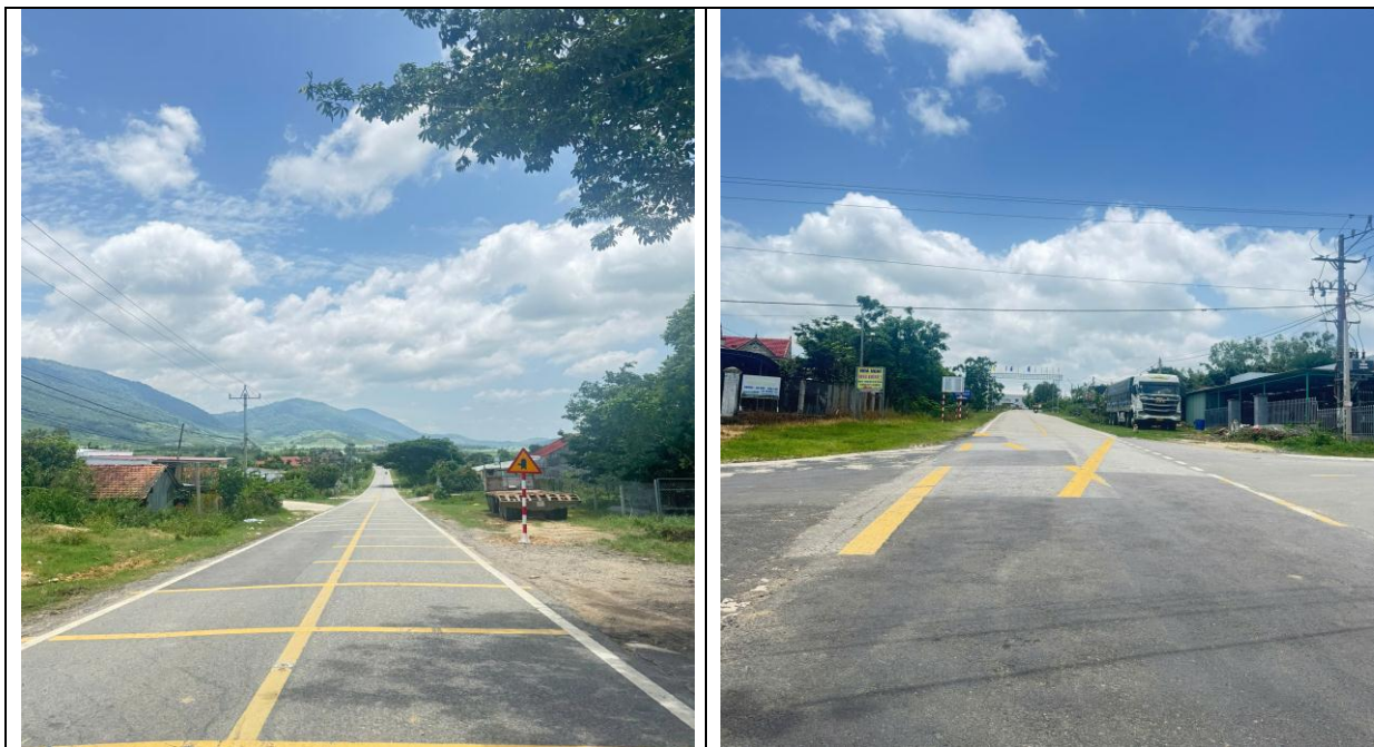
Hiện trạng tuyến giao thông đường Đông Trường Sơn xã Tơ Tung (cũ)
