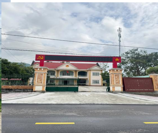
Hiện trạng công trình hành chính xã Tơ Tung (cũ) nay là Trụ sở Công an xã Tơ Tung (mới)
