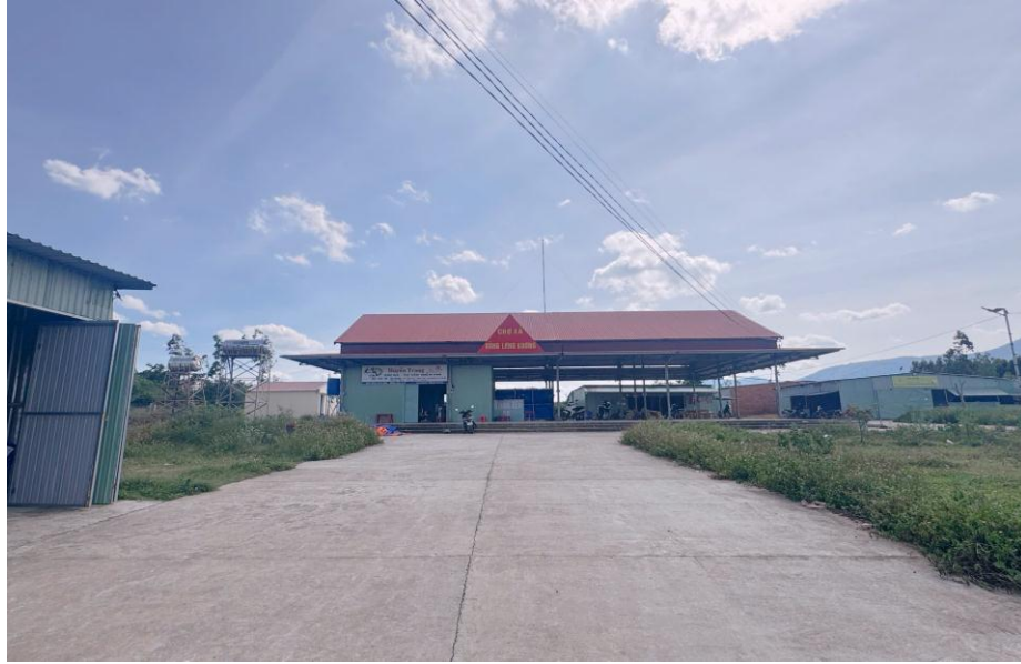
Hiện trạng Chợ xã Kông Long Khong (cũ)
