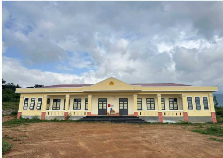
Hiện trạng công trình trụ sở Công an xã Kông Long Khong (cũ)
